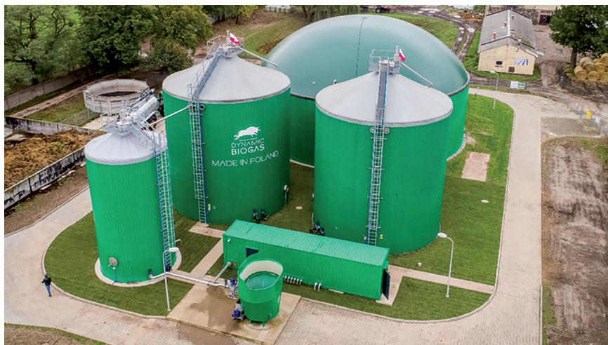
Rysunek 4. Widok biogazowni eksperymentalnej w Przybrodzie (źródło: J. Dach)
