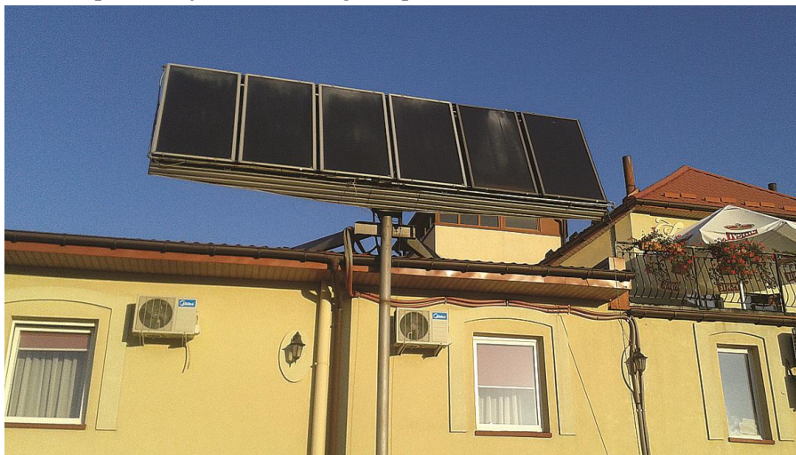
Fot. Z Ginalski – Nadążny panel fotowoltaiczny, woj. podkarpackie
