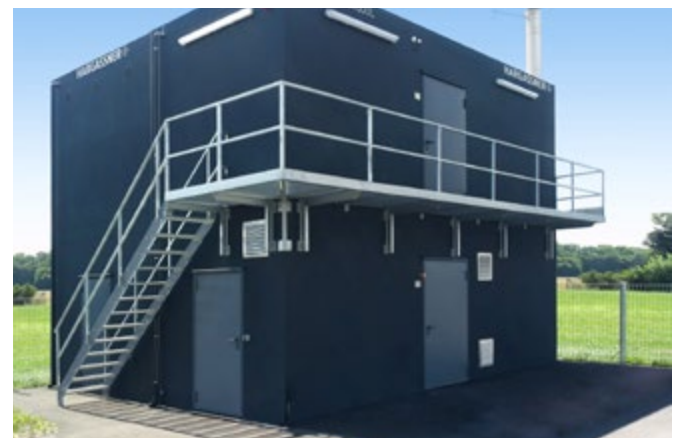
Vierfach-Hackgut-Heizmodul bei einem Industriegebäude.
